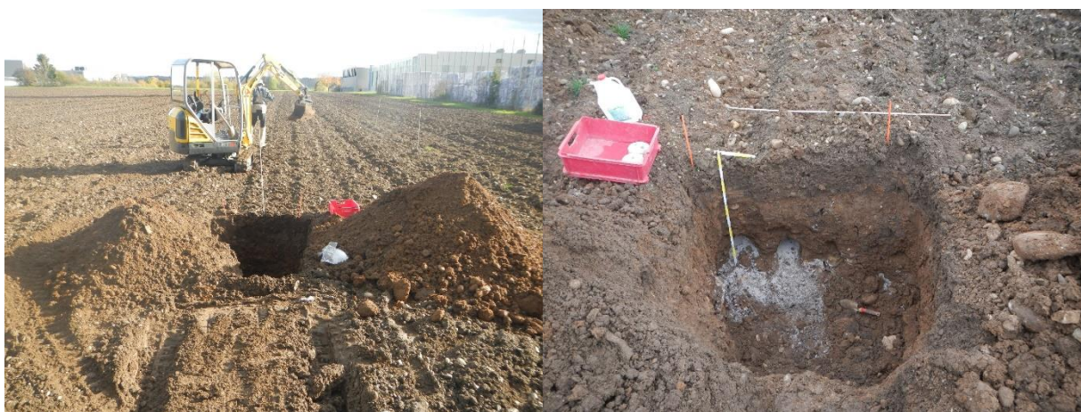
Abbildung 7: Einbau der SIA in 80 cm Tiefe.
