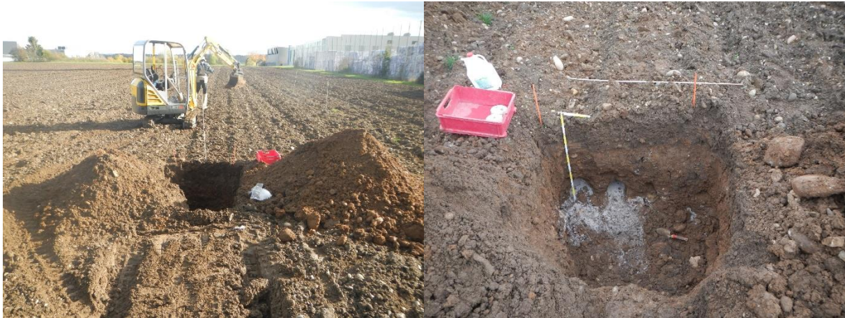
Abbildung 7: Einbau der SIA in 80 cm Tiefe.
