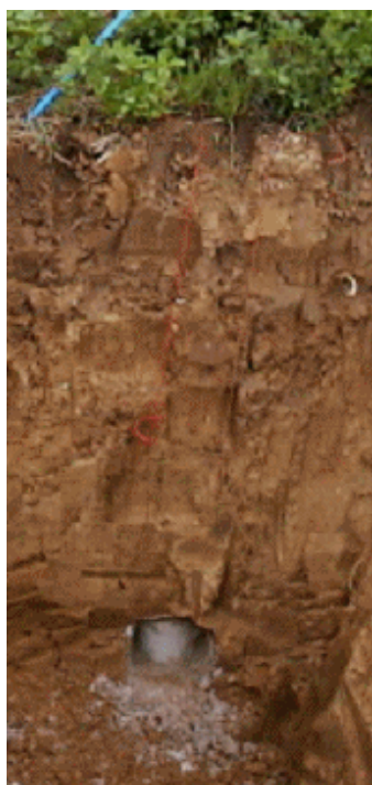
Einbau eines SIA unter ungestörtem Boden
